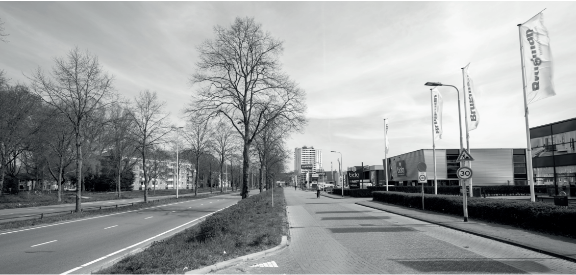
Huidige situatie Ringbaan-Zuid: Een omgeving waarin de auto de maat der dingen vormt. Bebouwing staat ingetogen of afgekeerd van de rijbanen en op ruime afstand. Het extensieve ruimtegebruik biedt kansen voor verdichting.
