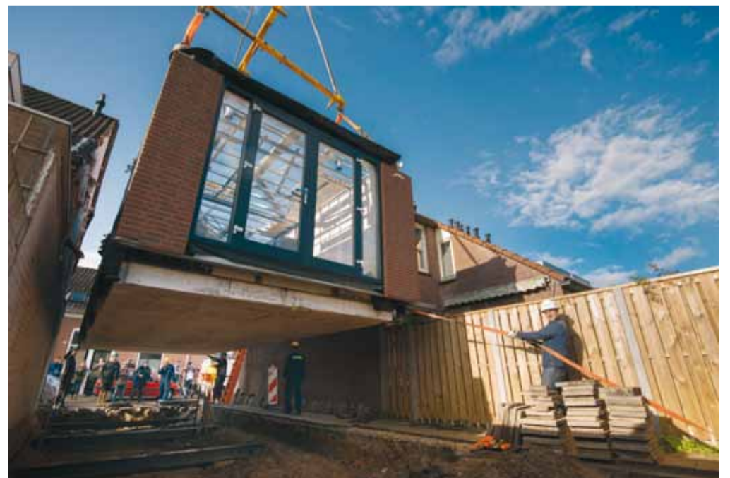
De pre-fab begane grond-etage wordt op zijn plek gehesen.
