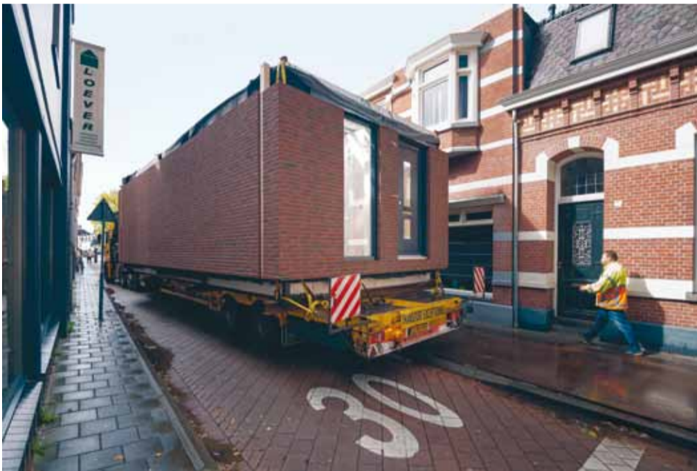
De pre-fab begane grond-etage wordt aangeleverd
