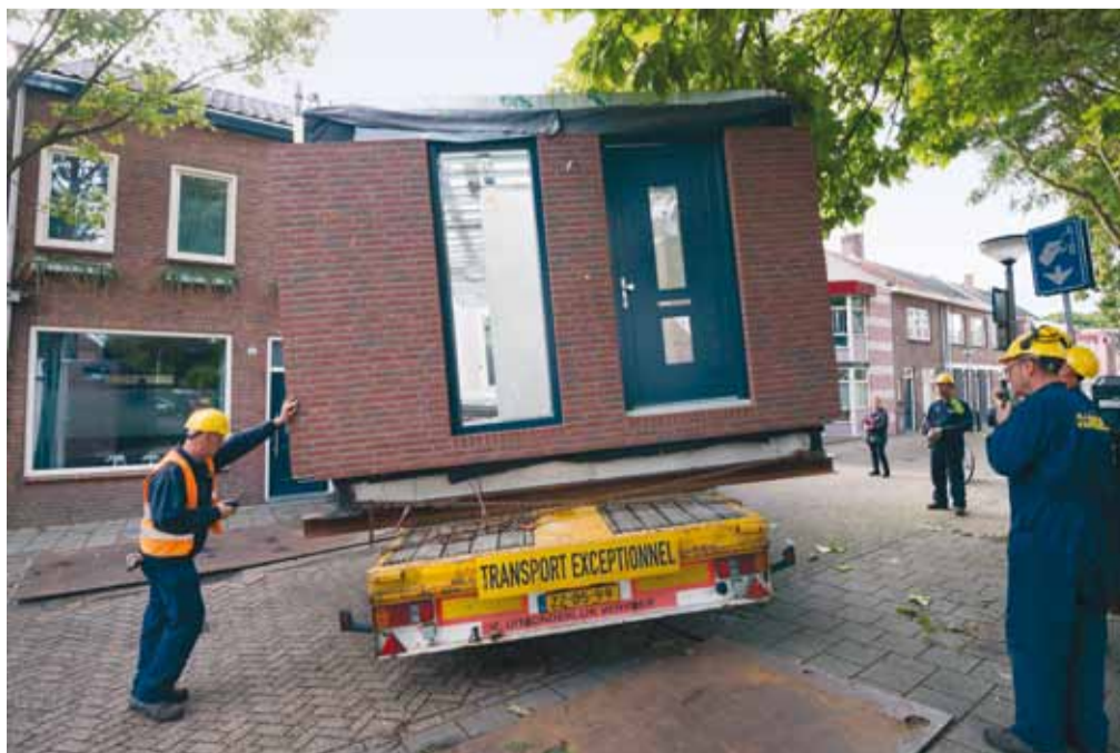
De pre-fab begane grond-etage wordt aangeleverd
