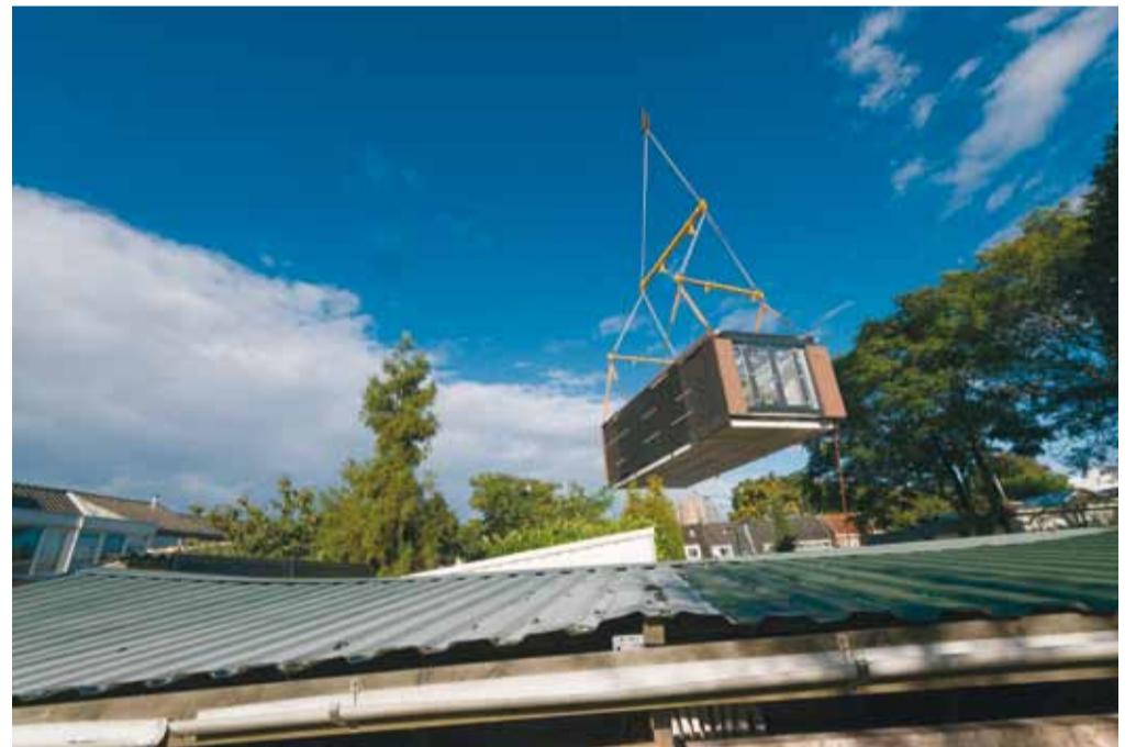
De pre-fab begane grond-etage wordt op zijn plek gehesen.
