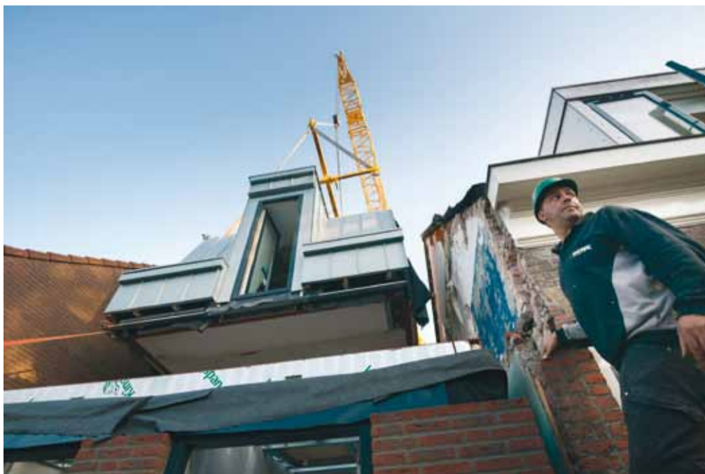
Vervolgens wordt de eerste etage op de begane grond-etage gehesen.
