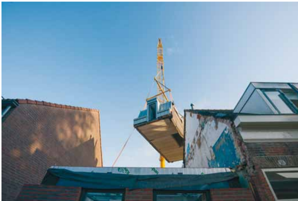
Vervolgens wordt de eerste etage op de begane grond-etage gehesen.
